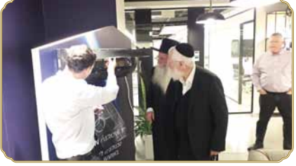
ראש המכון הגרא"מ הלפרין שליט"א יחד עם הרה"ג ר' יעקב לוריא בבדיקת הרכיב החדש מותקן על מזגן
